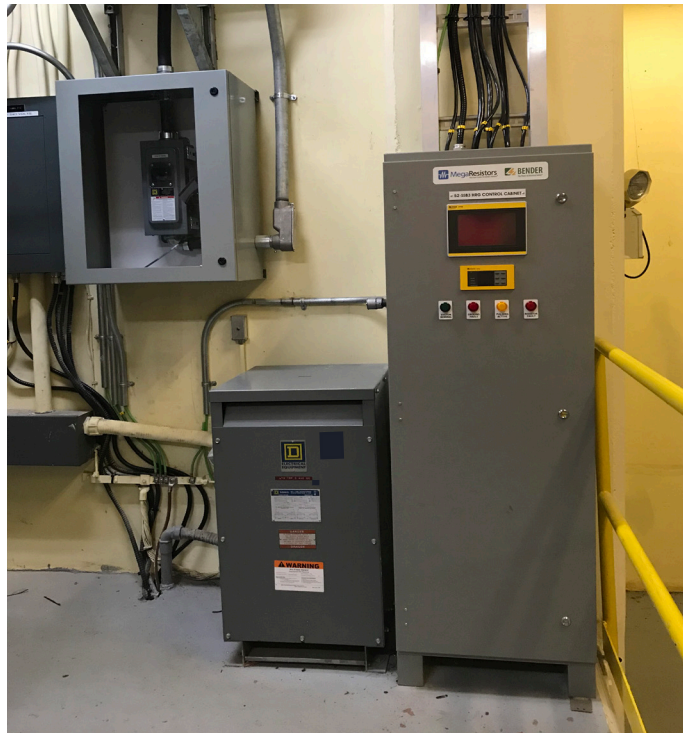
Ilustración 3: Panel de control de una HRG con monitores NGRM700 y RCMS490 en su interior
