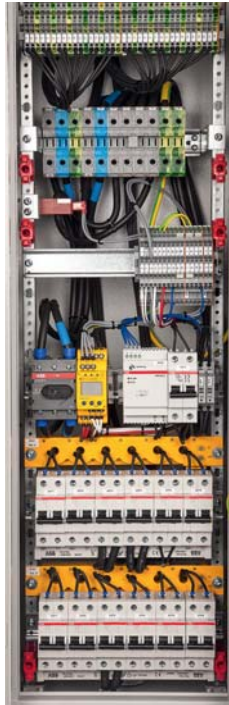
Verteiler IT-System mit Isolationsüberwachungsgerät isoMED427P
