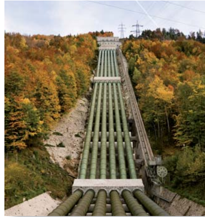
Druckrohrleitungen eines Pumpspeicherkraftwerkes
