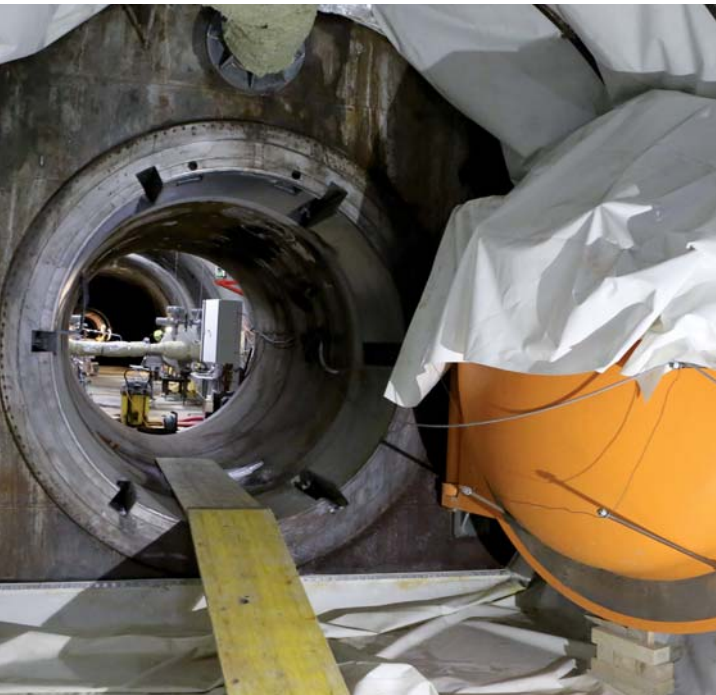
Der Speicherraum für die Druckluft wird begrenzt von einem Betoneinsatz mit 5 m Durchmesser sowie einer Metalltüre.
